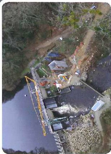
Construction de la nouvelle unité de Production de Tréaraway II - exhaure
