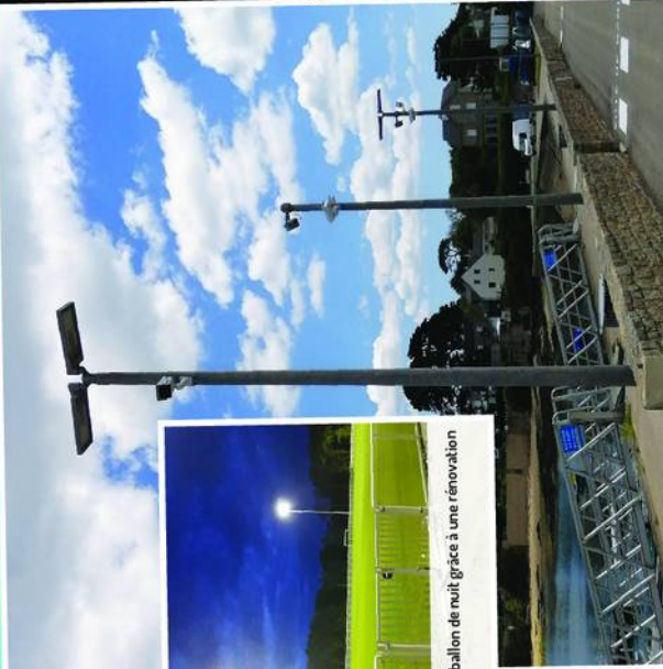
L'éclairage public peut offrir d'autres fonctions comme ici pour de la vidéo-protection sur le parking de la Crée à Port-Navalo.
