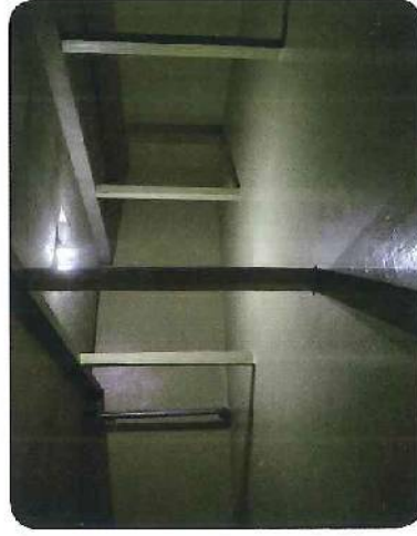
Cuve intérieure du réservoir d'Antoureau - LE PALAIS
