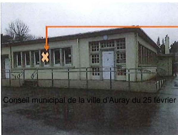
Photo n°1 : Vue extérieure du bâtiment
