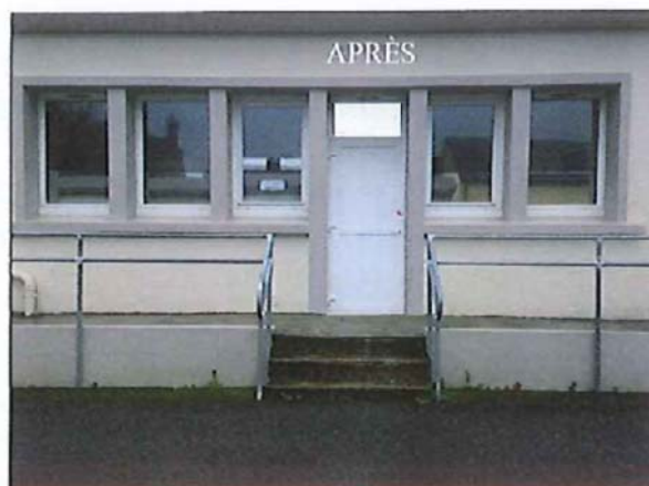
Photo n°3 : Représentation faisant apparaître la création de l'ouverture
