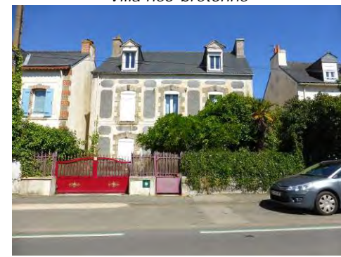
Avenue du Général de Gaulle (Vo)
