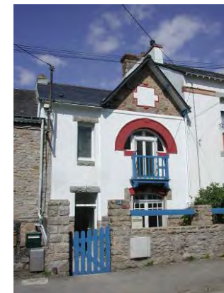
Lotissement du Chemin noir. Rue Jean Jaurès
