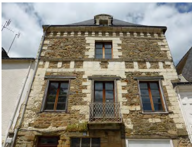
Pierre calcaire (tuffeau) de couleur blanche. Le moellonnage en granite était destiné à être enduit. Maison rue du Château.
