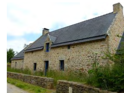
Maison à Keropert.
