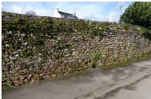
Mur plein, moellonné, toute hauteur (2,20 à 2,50 m)
