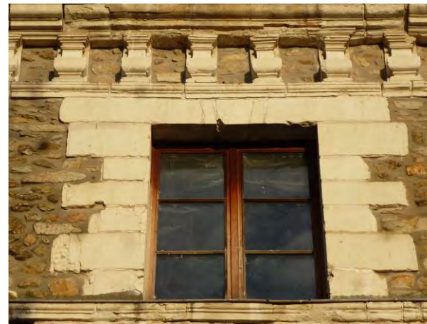
Cordon d'appui, corniche, décor de balustres, encadrement de fenêtre en tuffeau.
