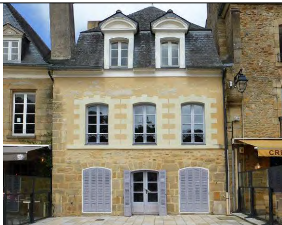
Exemple d'enduit de qualité : appliqué de manière pelliculaire, sans épaisseurs, sans boursouflures et de ton clair à peine coloré
