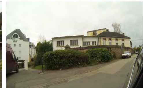
Au sud de l'enclos, marqué par une forte dénivellation, une partie du bâti peut être démolie pour lier la rue des Tilleuls au cœur de l'îlot. Le bâti à encadrement de baies en briques, à droite, peut être maintenu.
