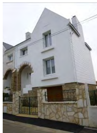
Quartier de Kerdrain. Rue Sombreuil
