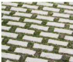
Pavage en béton avec ouvertures de drainage
