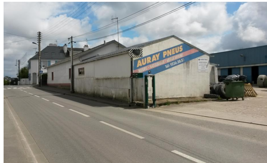
2/ Entreprise au Nord-Est, bâtis à démolir
