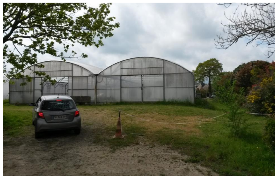
2/ Accès au site, situé au Nord-est
