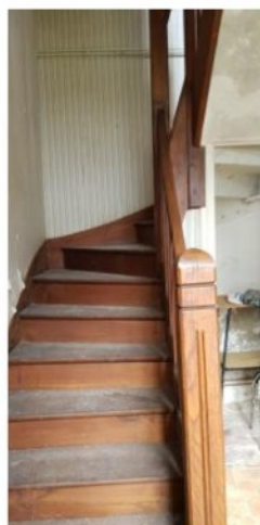
Escalier en bois
