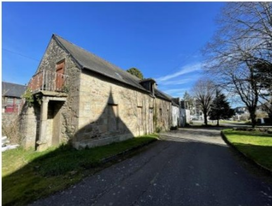
Pignon Ouest, escalier en pierre
