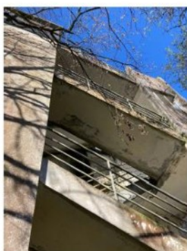
Escalier béton et ascenseur extérieur
