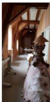
Circulation R+1 en bon état
