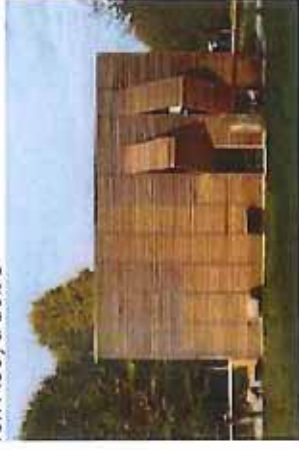
Facade Extérieure Mise en place de volet papillon qui crée un jeu de facade et de rythme selon les ouvertures des Halles + protection brise-soleil et pluie ref. Acroyc Bois®
