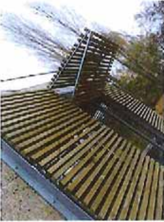
Facade Extérieure Mise en place de volet papillon qui crée un jeu de facade et de rythme selon les ouvertures des Halles + protection brise-soleil et pluie ref. Acroyc Bois®
