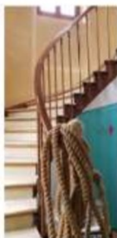
Escalier circulaire en bois
