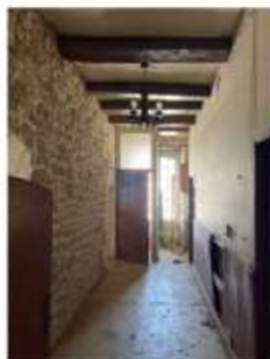
Circulation en bon état
