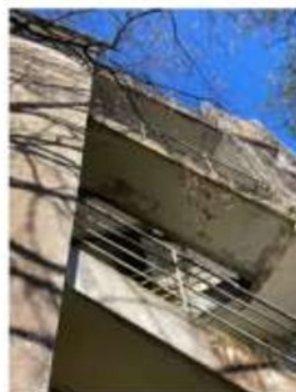
Escalier béton et ascenseur extérieur
