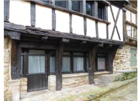
Lorsqu'une maison à pan de bois est construite sur poteaux en bois, la devanture doit être positionnée entre ces poteaux ou légèrement en retrait.
