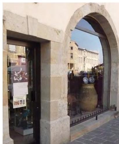
Lorsqu'un dispositif anti-bélier est nécessaire, celui-ci doit être réalisé en arrière du vitrage ou de manière discrète en ferronnerie.
