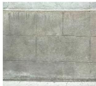
Un enduit en « coupe de pierre » peut être admis en chaînage d'angle et en soubassement des façades, sur environ 1,20 m de hauteur, lorsqu'il n'y a pas de pierre intéressante.
